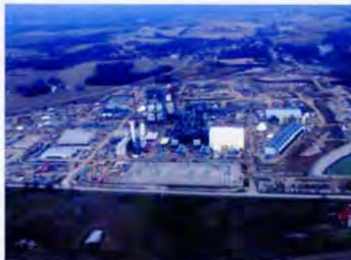
Рис. 3 Duke Energy: установка Edwardsport IGCC. Подготовка к началу тестовых испытаний. Передача в эксплуатацию в 2012 году.
